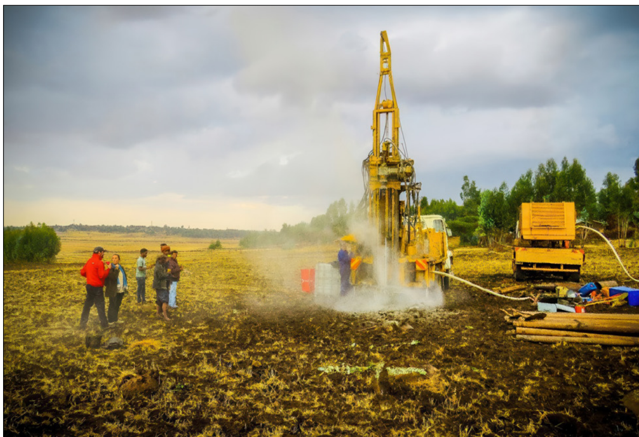
Perforación Pozo n°100 en North Shewa en la región de la Oromía, Etiopía.
