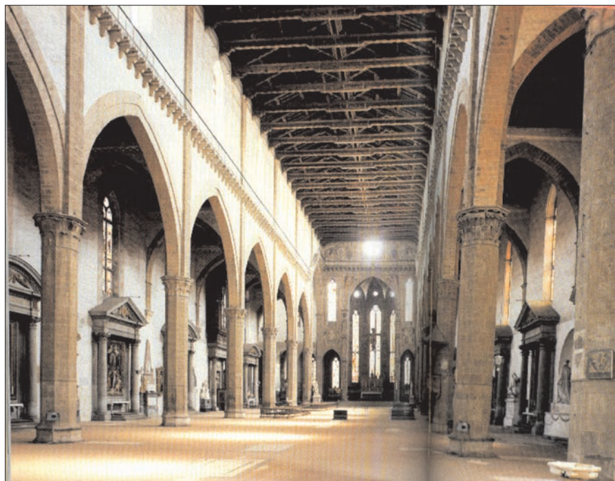
FIGURA 2. Arcos y bóvedas de madera de la basílica de la Santa Croce .
